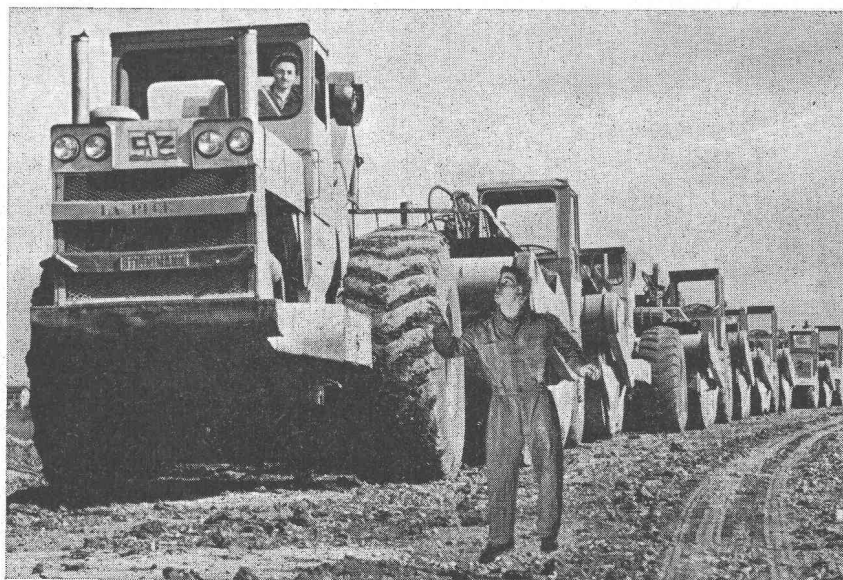
SCRAPERS CHARGE 21 To PUISSANCE 274 CV POUR CONSTRUCTION D'AUTOROUTES
