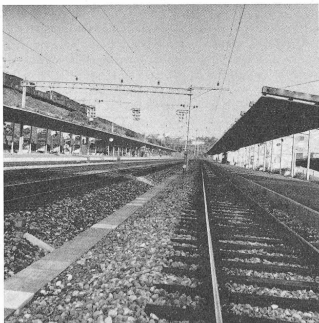
Fig. 1. — Les quais de la gare Expo. — à gauche, le quai nord ; — à droite, le quai sud. — au milieu, la double voie Lausanne-Renens.
