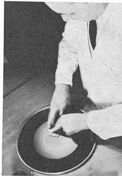
Fig. 24. Rodage au tour d'opticien.
