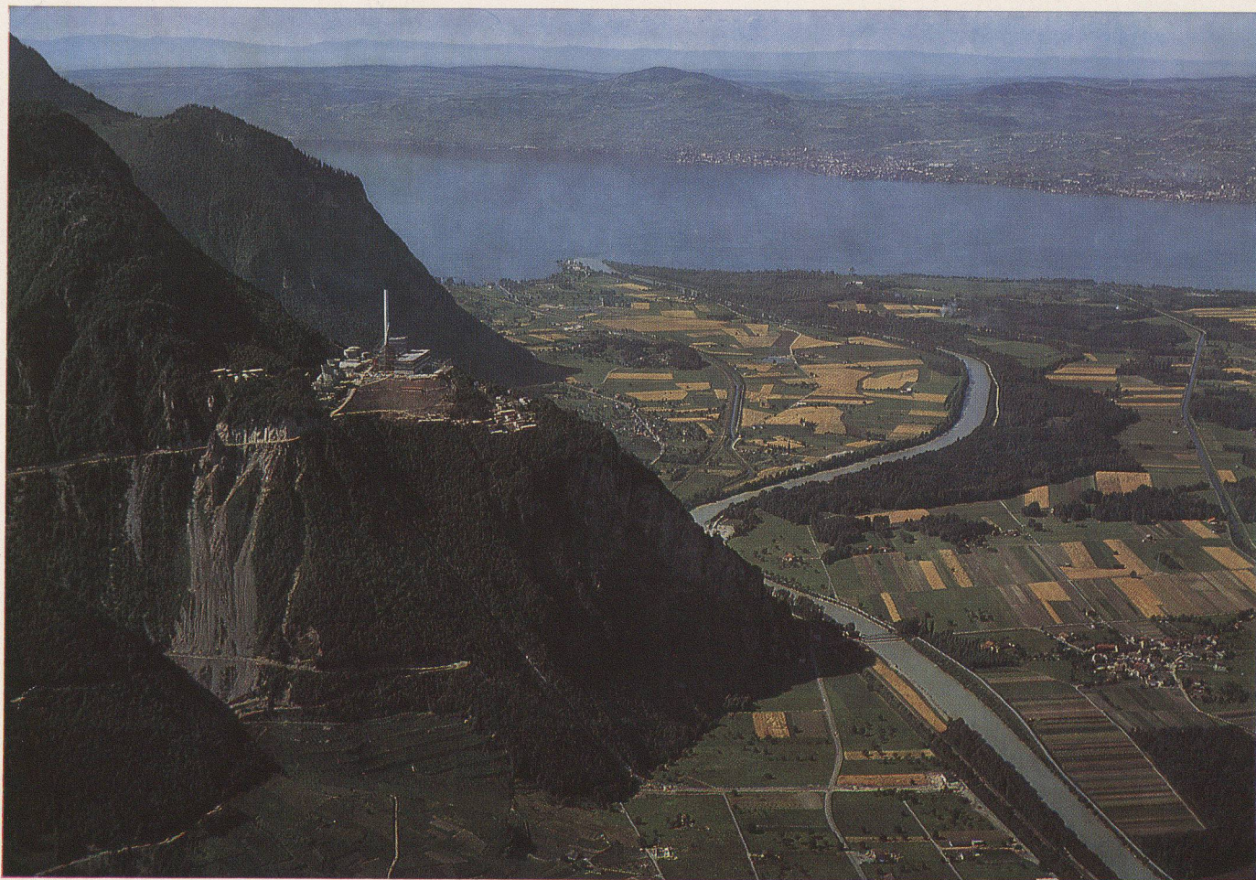
Vue générale de la centrale thermique de Chavalon-sur-Vouvry.
