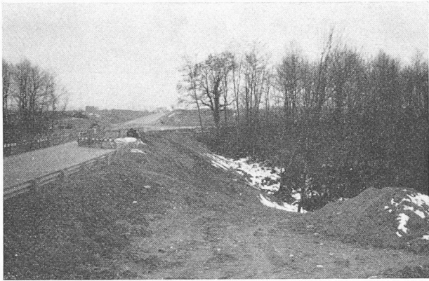
Fig. 3. — Satigny. La route et le talus amont, vue prise en direction de Russin.
