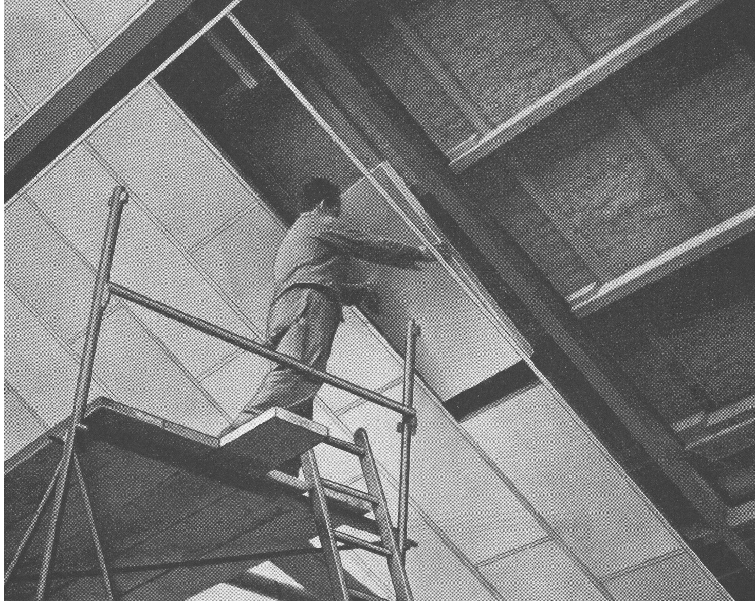
Plafond de local industriel avec panneaux en fibres de verre Vétroflex revêtu une face aluminium, type Shedisol
