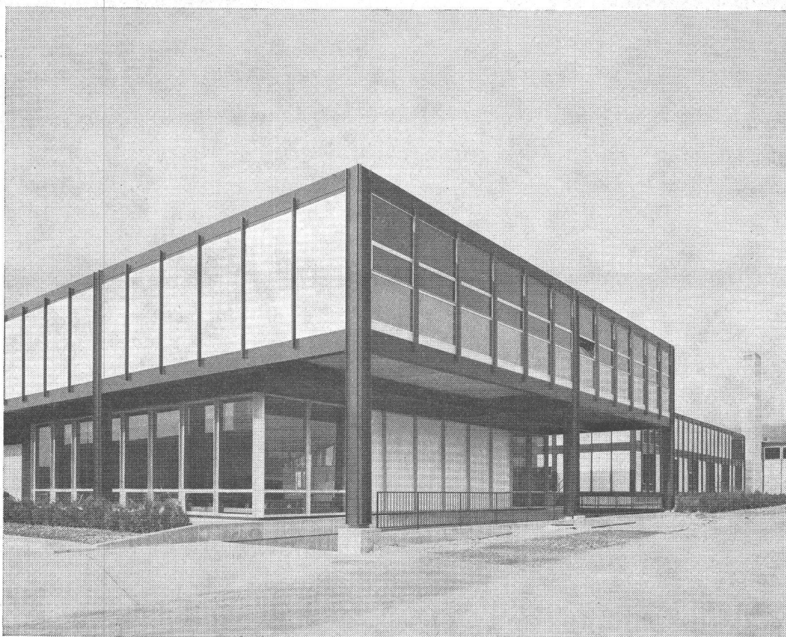
Centre de la Voirie des Vernets, Genève Architectes: J.-P. Dom, F. Maurice, L. Parmelin
