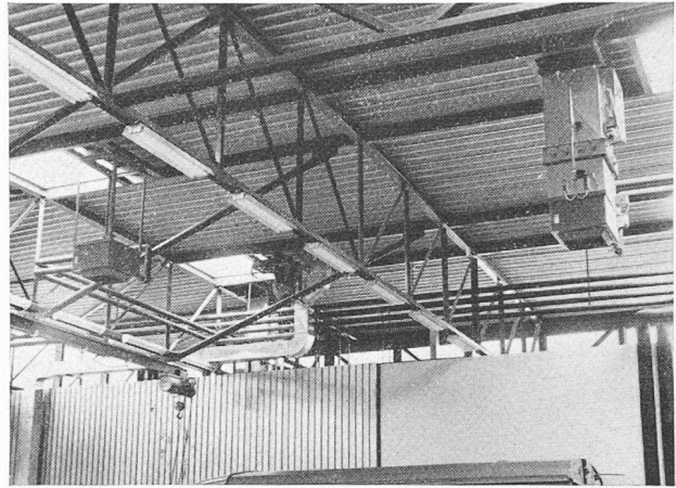
Fig. 8. — Vue du plafond d'un atelier.
