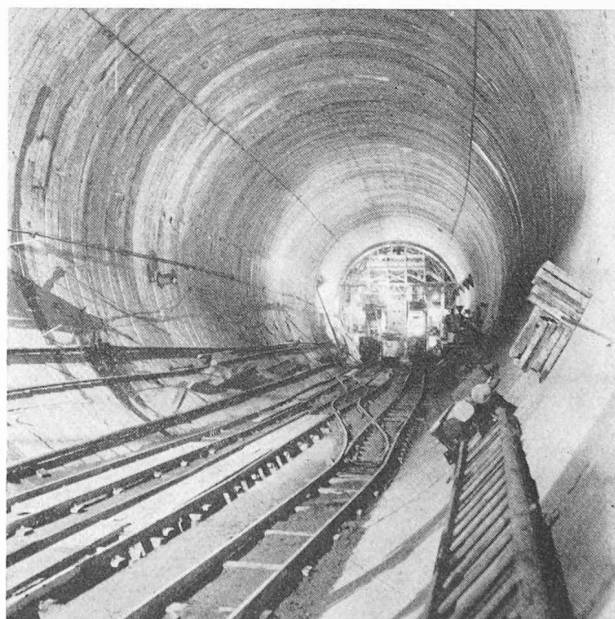
Fig. 3. — Vue du tunnel en construction.
