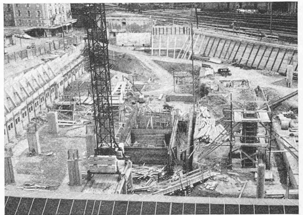
Fig. 5. — Etat du chantier, en cours d'exécution des sous-sols. On distingue le mur côté voies et le mur autostable le long de l'avenue d'Ouchy avec butons obliques.
