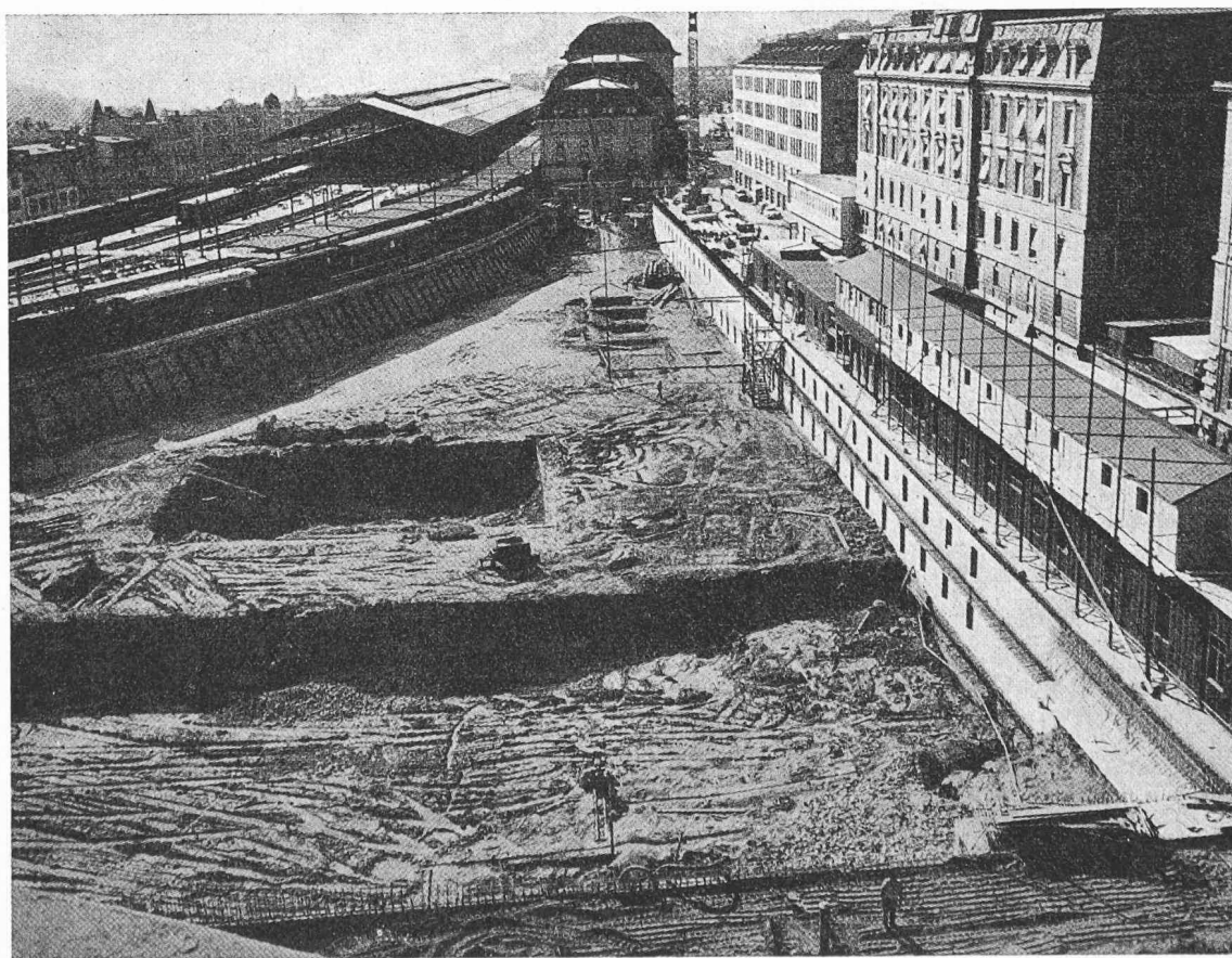
Fig. 1. — Ouverture de la fouille générale. On distingue les deux murs d'enceinte : le mur côté voies avec son étayage, et le mur d'enceinte nord autostable.
