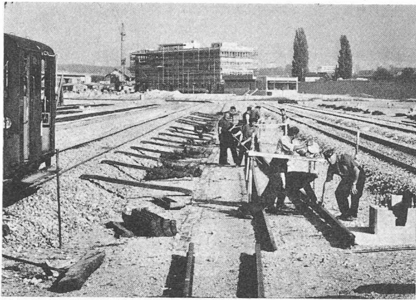
Fig. 10. — Pose de la voie dans le faisceau de formation. A l'arrière-plan : le bâtiment de service principal. (Photo OFF)
