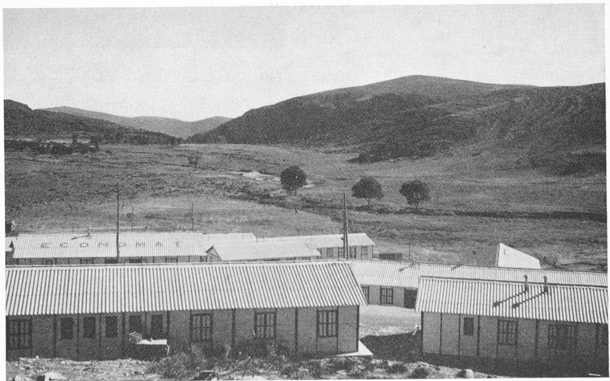
Fig. 12. — La vallée du Meffrouch, à l'aval du barrage. Au premier plan, le village du chantier.
