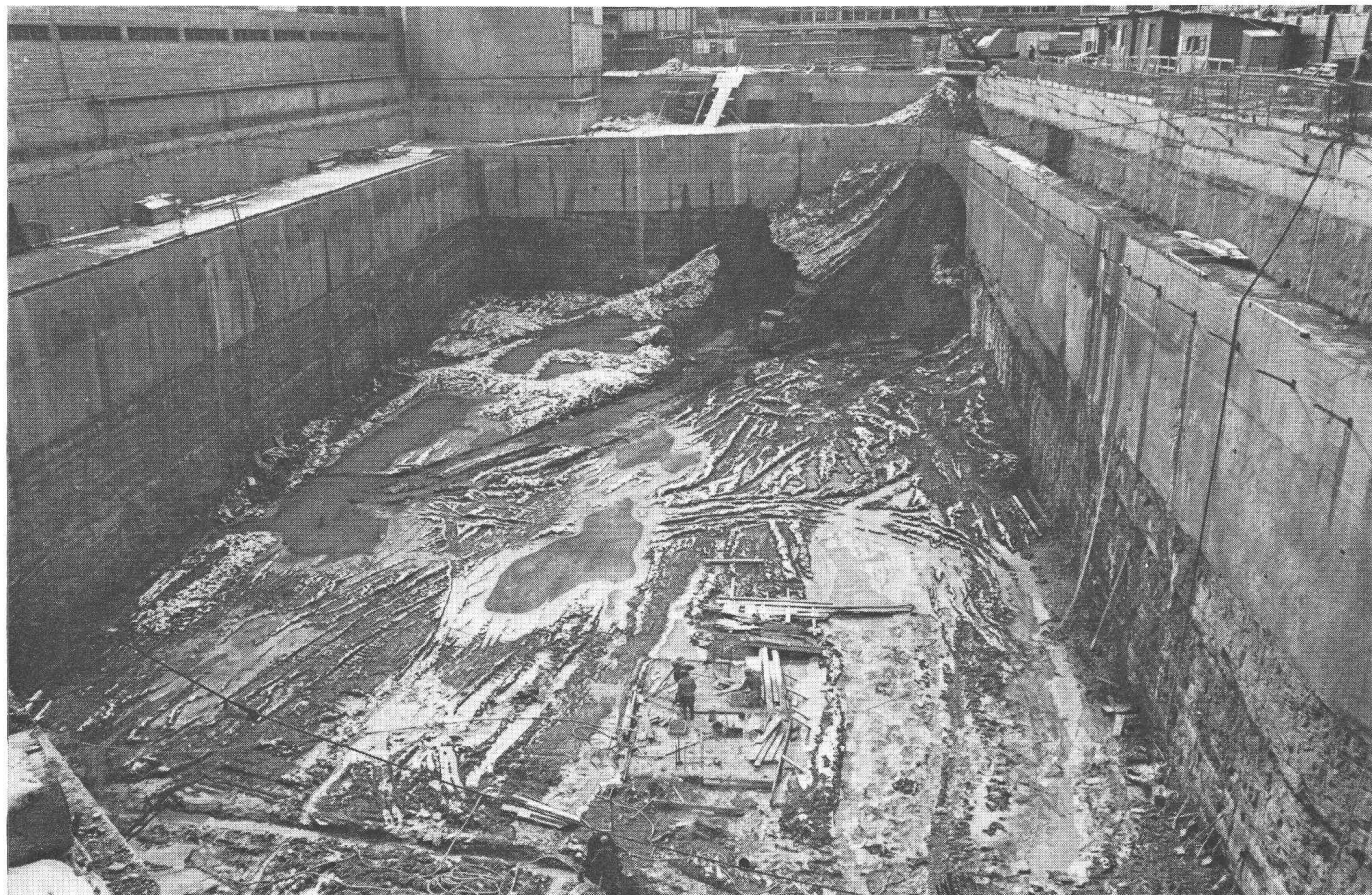
Garage Arve-Rhône, Genève. Parois moulées dans le sol
