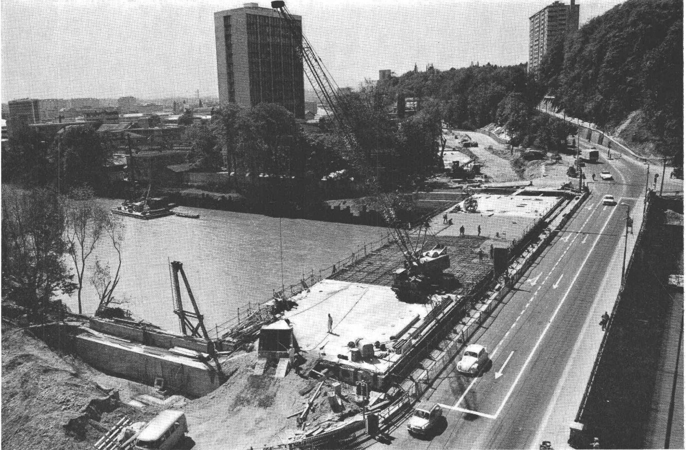
Pont de St-Georges sur l'Arve, Genève Bétonnage du tablier sur éléments préfabriqués
