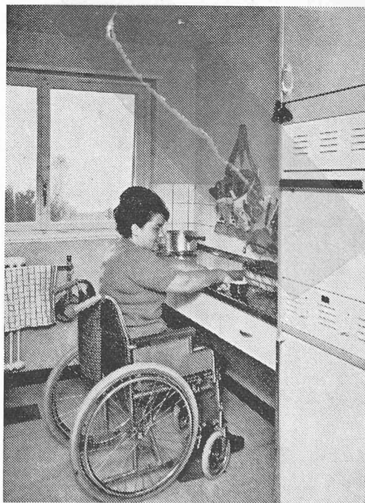
Fig. 7. — Cuisine avec plan de travail permettant l'approche en fauteuil roulant selon la norme SNV 521 500.
