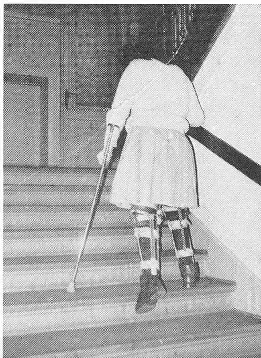
Fig. 5. — Un pied paralysé reste accroché au nez débordant de la marche. Les marches à angle droit, sans saillie, sont plus faciles à monter.
