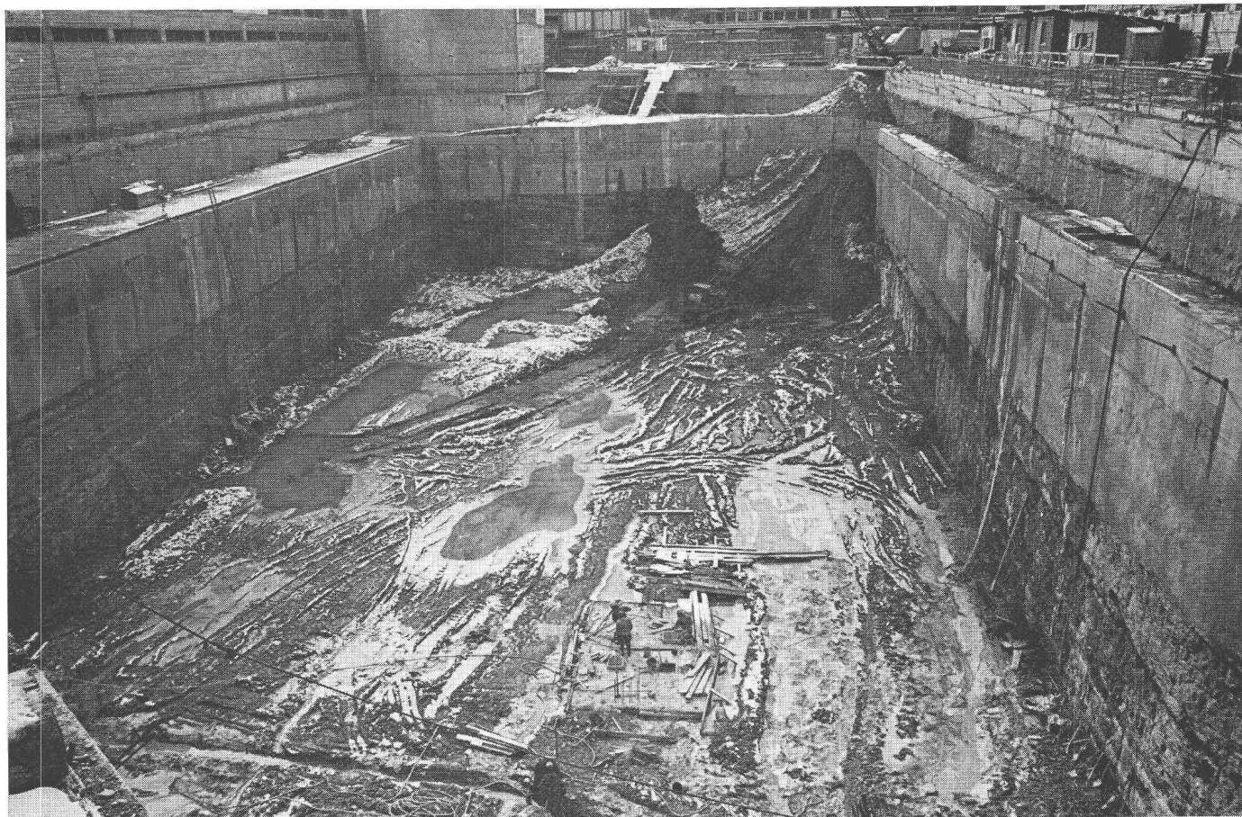
Garage Arve-Rhône, Genève. Parois moulées dans le sol
