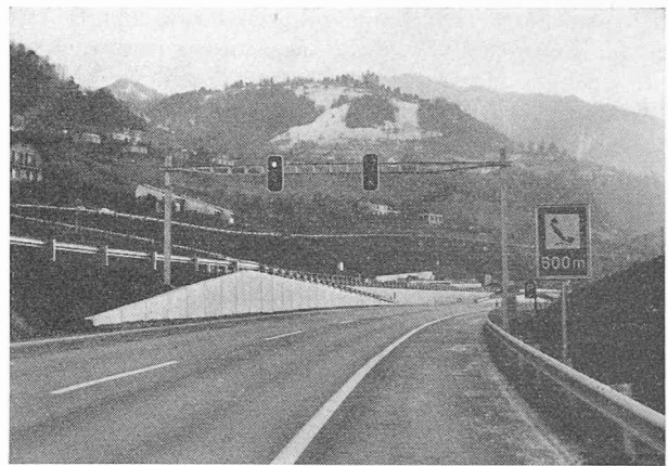
Fig. 6. — Signalisation par feux lumineux précédant les tunnels de Glion.
