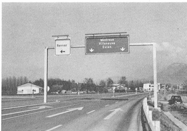
Fig. 3. — Portique de signalisation à Rennaz.
