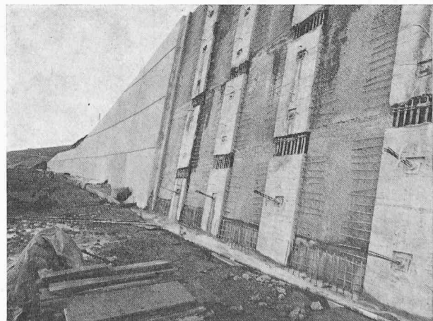
Fig. 5. — Mur ancré, vue avant la pose du béton de parement.
