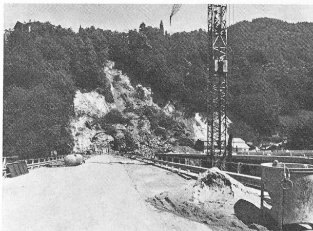
Fig. 4. — L'éboulement de mai 1968
