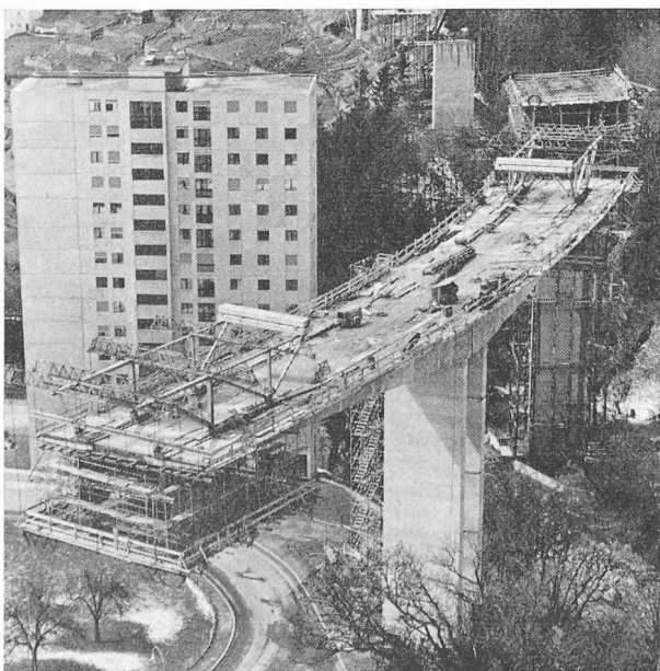
Fig. 6. — Vue sur la palée 2 et l'extrémité du pont côté Lausanne.
