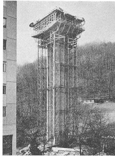
Fig. 7. — Palée 3 prête à recevoir les chariots.
