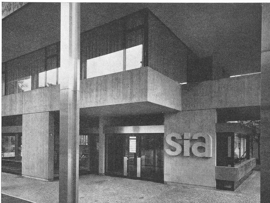
Entrée de la maison SIA à la Selnaustrasse, avec le sigle de Franz Purtschert. A gauche, le restaurant (non terminé).
