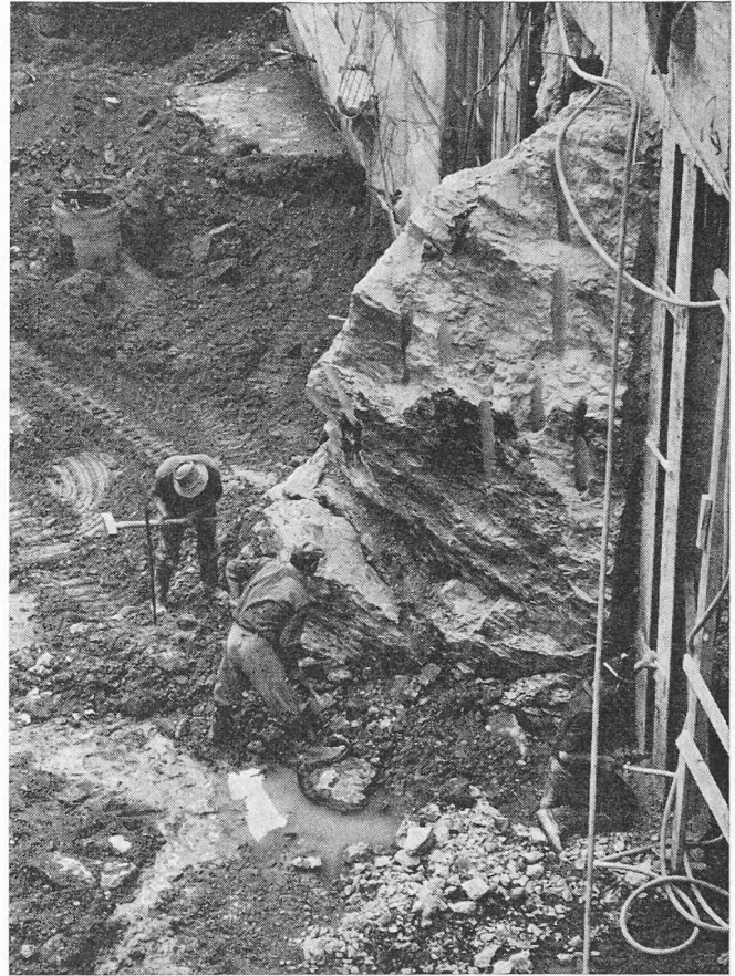
Fig. 1. — Démolition d'un des plus gros blocs erratiques. La paroi berlinoise dut être interrompue.
