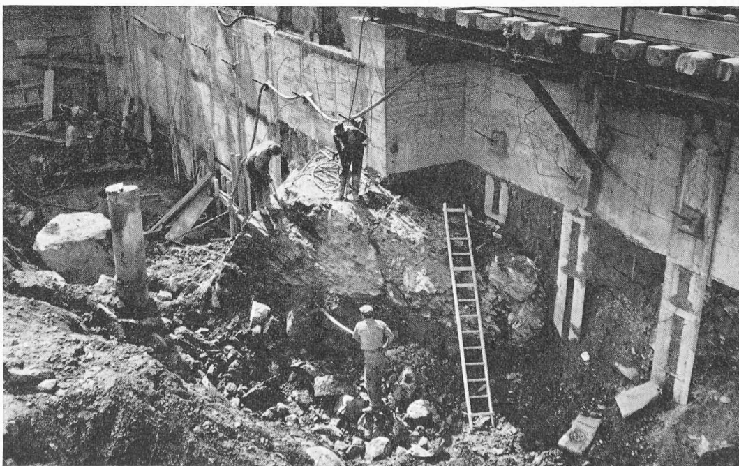
Fig. 2. — Bloc erratique dans la fouille ; têtes des ancrages supérieurs.
