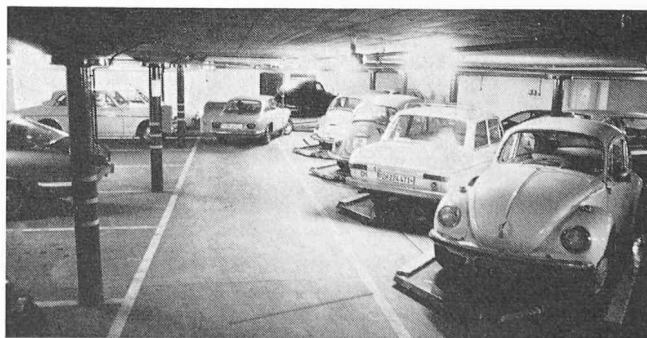
Fig. 3. — Une voiture monte sur une plate-forme. Les plates-formes voisines se sont écartées automatiquement pour faciliter la sortie des personnes des deux côtés de la voiture (disposition B de la fig. 1).
