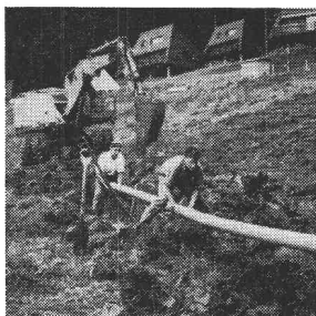
Canalisation Schwyz: Rothenturm
