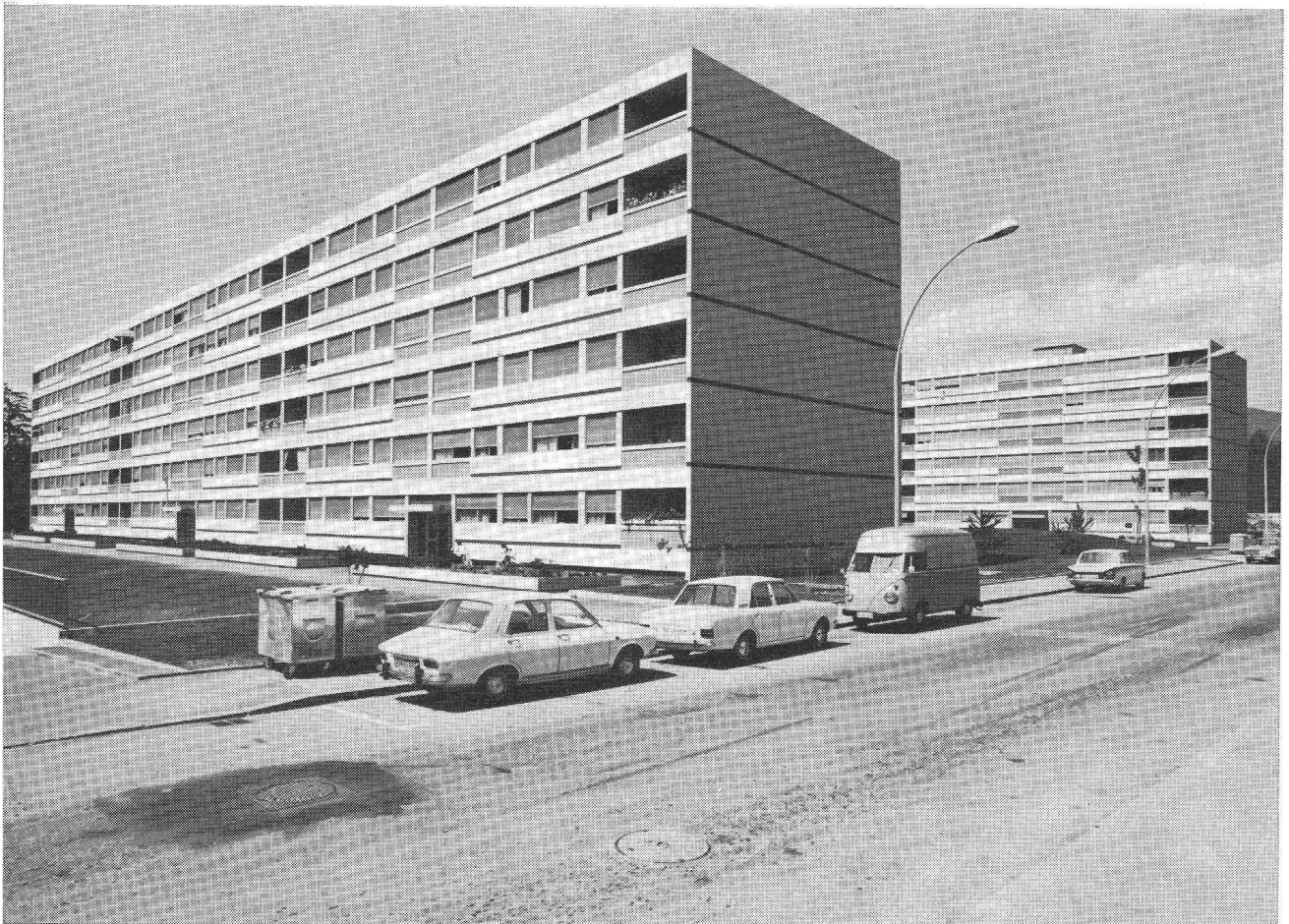
SI Meyrin-Sud, 216 appartements HLM Projet: MM. Hermès & C ie , architectes SIA-AGA, Genève Bureau d'étude S. A. Conrad Zschokke (statique et béton armé) Exécution en entreprise générale 1969/71
