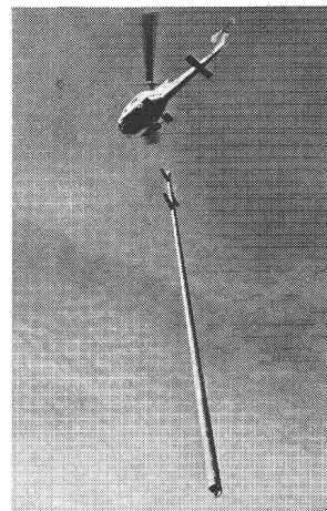
Transport d'un poteau de 26 m
