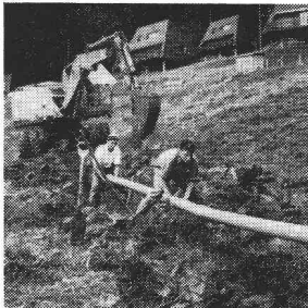
Canalisation Schwyz : Rothenturm
