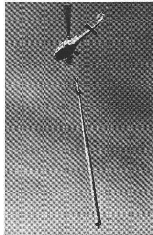
Transport d'un poteau de 26 m
