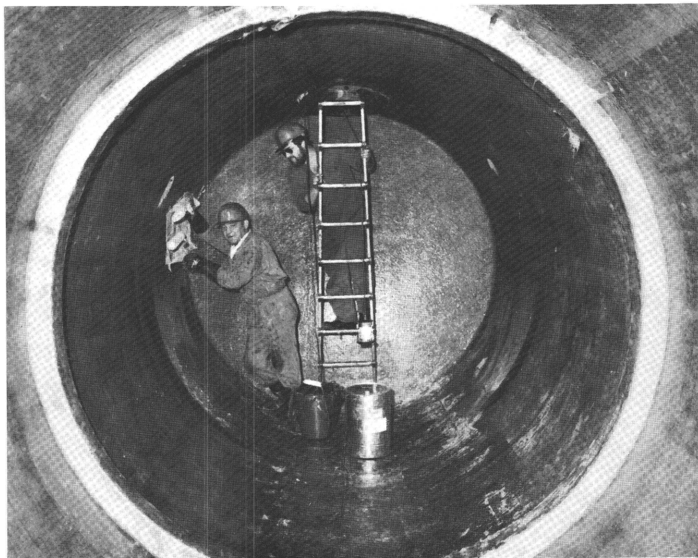
Citerne sous terre et sous chaussée reconstituée en polyester COLMASYN de SIKA S.A. Photo: Meystre, Genève
