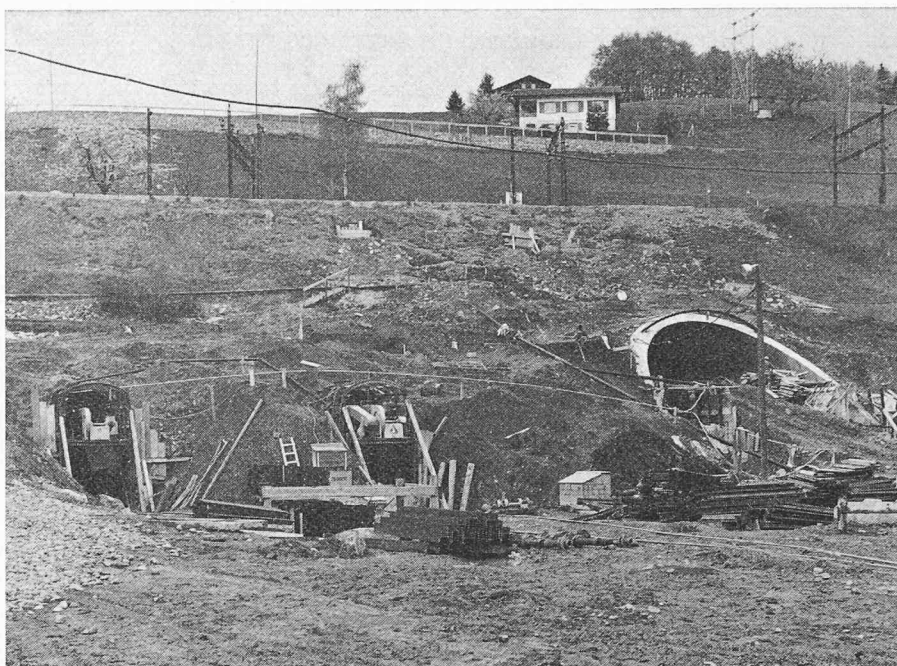
Fig. 3. — Vue des entrées Est. Tunnel amont : excavation de la calotte terminée. Tunnel aval : exécution des galeries de base.
