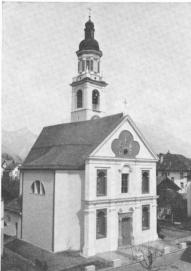
Fig. 9. — Eglise de Rhäzuns. Assèchement électro-osmotique des murs exécuté en 1968. (Photo C. Guler, Thusis.)
