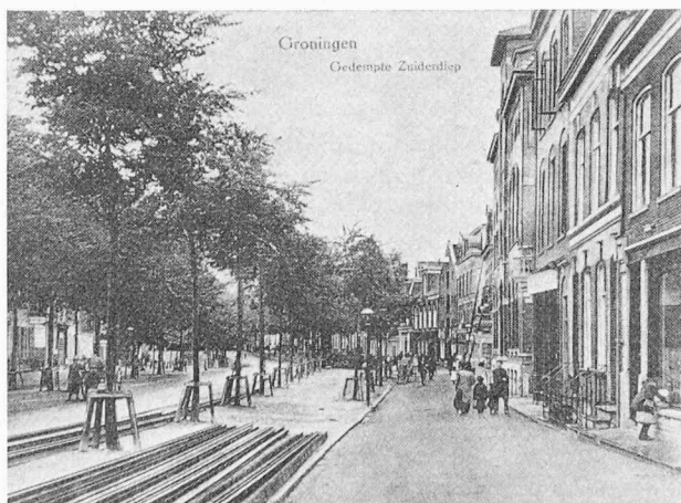
Fig. 13. — Photo des environs de 1910. Mise en place des rails pour le tram électrique, fonction de circulation en augmentation.
