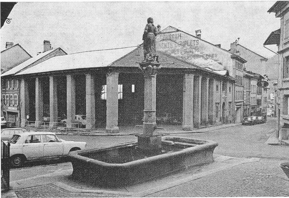
Fig. 28. — Moudon VD. La Grenette: le projet de la démolir pour les nécessités de la circulation et du stationnement a encore des partisans; il semble pourtant avoir du plomb dans l'aile.
