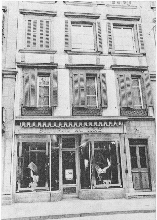
Fig. 43. — Yverdon VD . L'aspect vieillot de la devanture s'accorderait presque avec la façade si la porte du magasin n'était pas si maladroitement placée.
