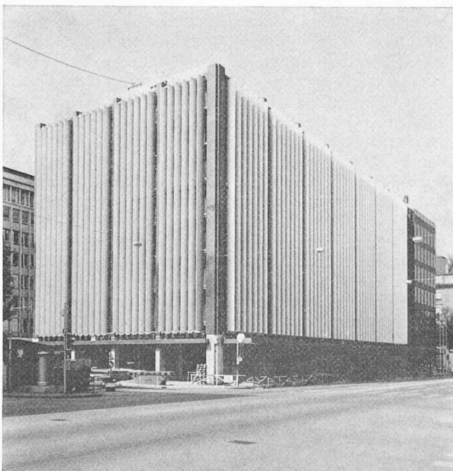
Fig. 4 et 5. — Deux récents exemples de la mode du brise-soleil genevoise. Les façades photographiées sont orientées vers le nord . L'inopportunité des protections solaires est évidente. (Photos KLEMM.)
