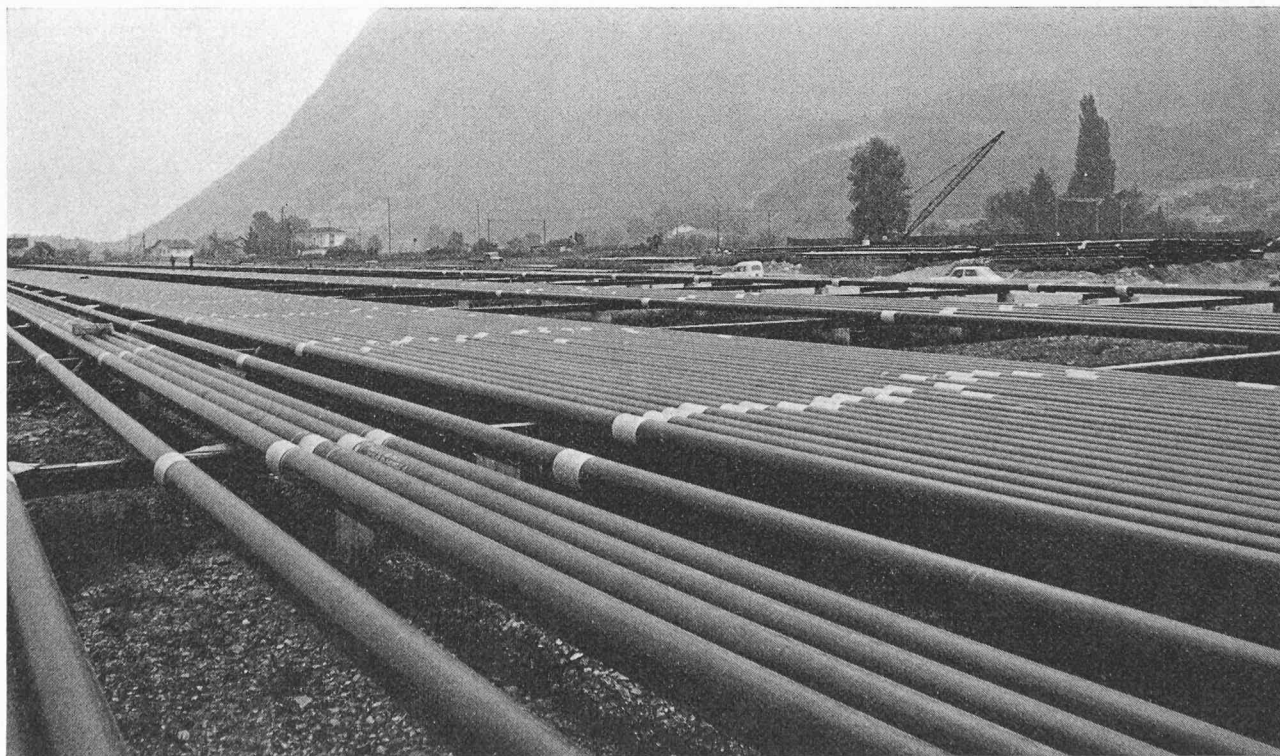
Fig. 4. — Le chantier d'assemblage des tubes au Bouveret.
