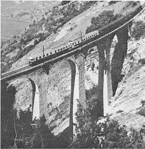
Fig. 20. — Viaduc du Luogelkin sur la rampe sud, avec une automotrice pour rames réversibles ABDe 4/8. (Photo BLS)
