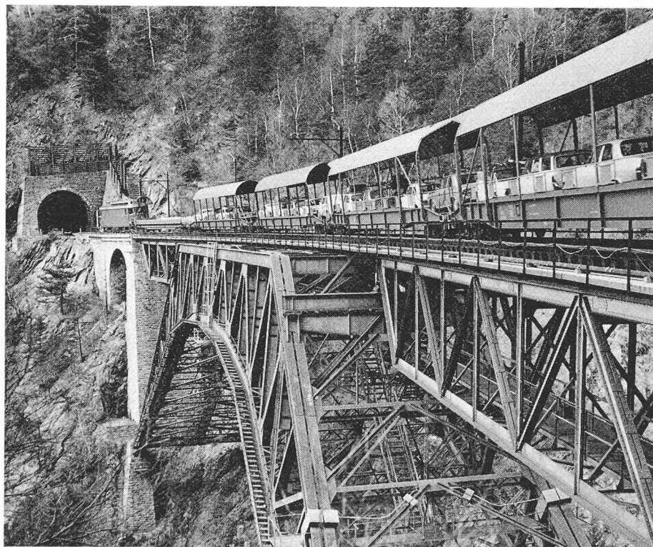
Fig. 19. — Viaduc du Bietschtal sur la rampe sud, avec un transport d'automobiles accompagnées (photo F. Marti/BLS).
