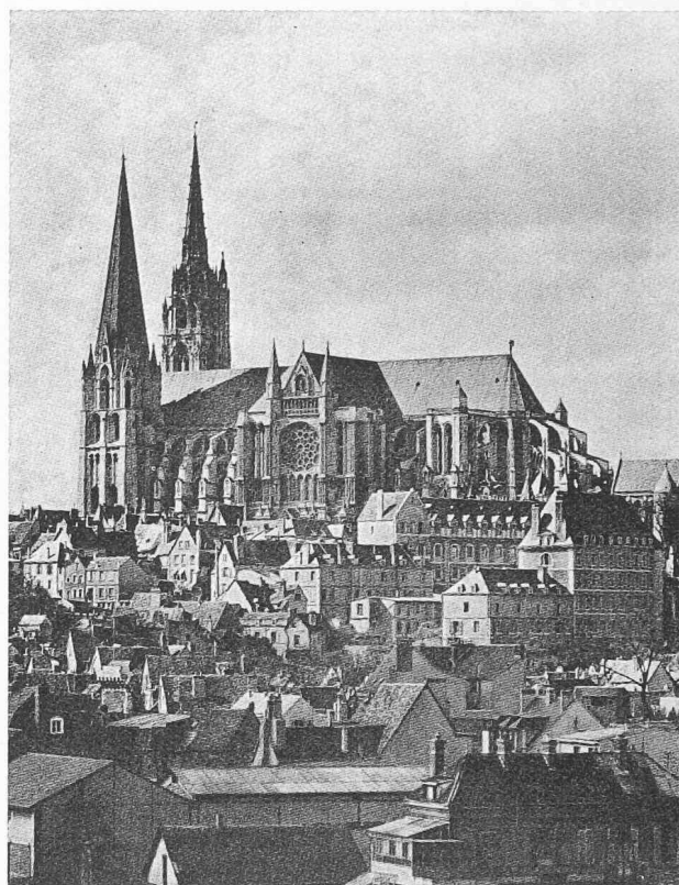
Fig. 16. — Cathédrale de Chartres, 1194-1220. Vue générale. Remarquer les tours de blocage indiquées à la figure 15 et les arcs-boutants.
