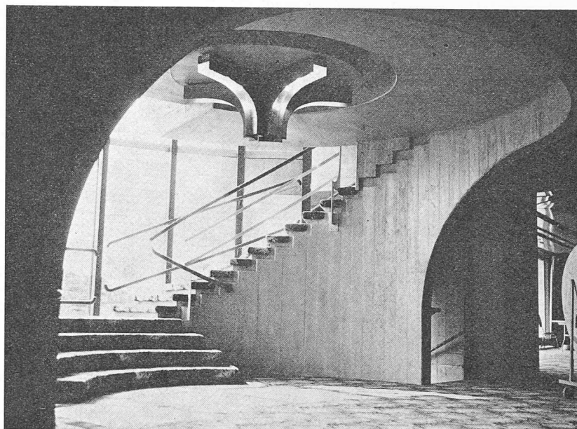
Fig. 12. — L'escalier reliant le niveau 2 au niveau 1.
