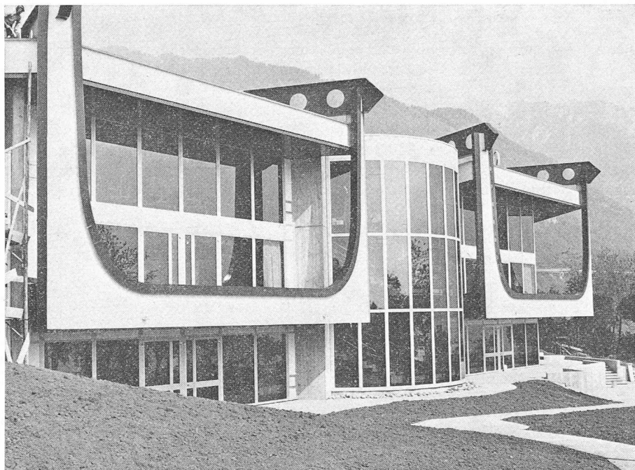
Fig. 1. — Le nouveau Casino ; façade sud.
