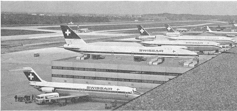
Fig. 1. — Le pavillon pour gros porteurs vu de l'aérogare existante. A l'arrière-plan : 1 Boeing 747 et 2 DC-10 stationnés aux places de débarquement et d'embarquement du nouveau bâtiment.
