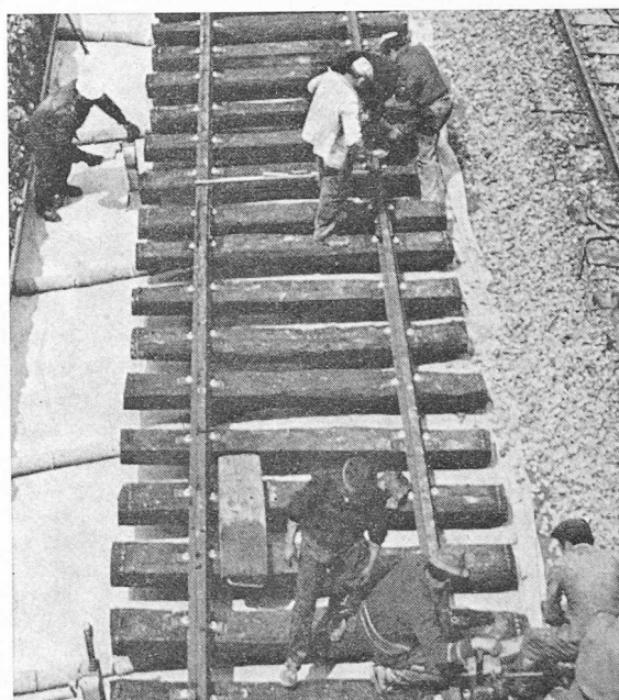
Fig. 2. — Pose de la voie sur une nappe synthétique non tissée « Bidim » 1 .
