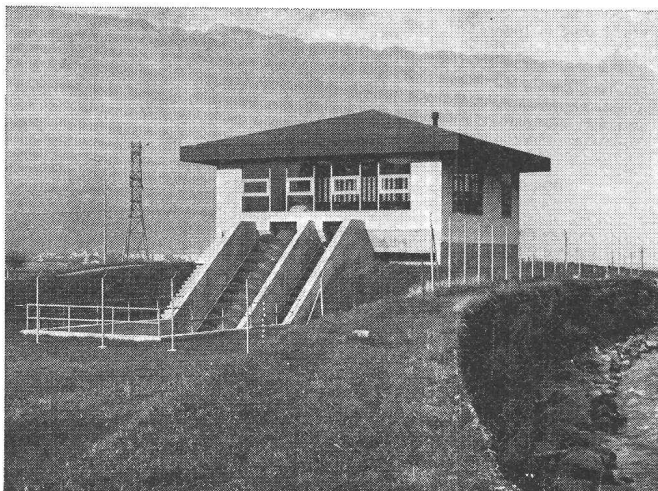
Station de relevage des eaux de décharge de la commune de Wilderswil.
