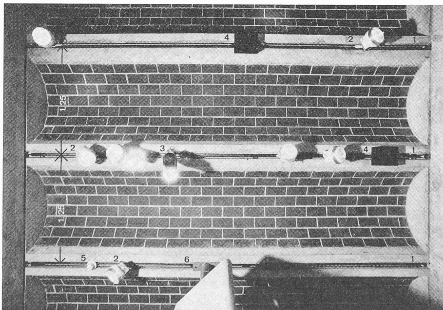
Fig. 11. — Equipement du plafond dans les salles d'exposition.
