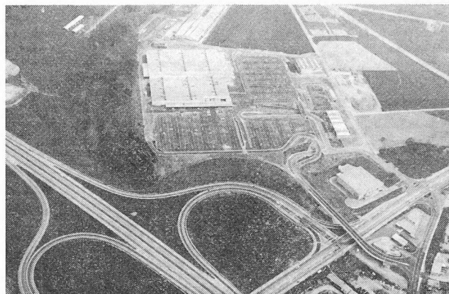
Fig. 6. — Vue aérienne du centre commercial Migros-MMM.
