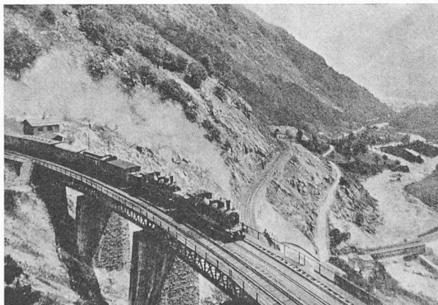
Fig. 3. — Traction à vapeur au Saint-Gothard, vers 1895.
