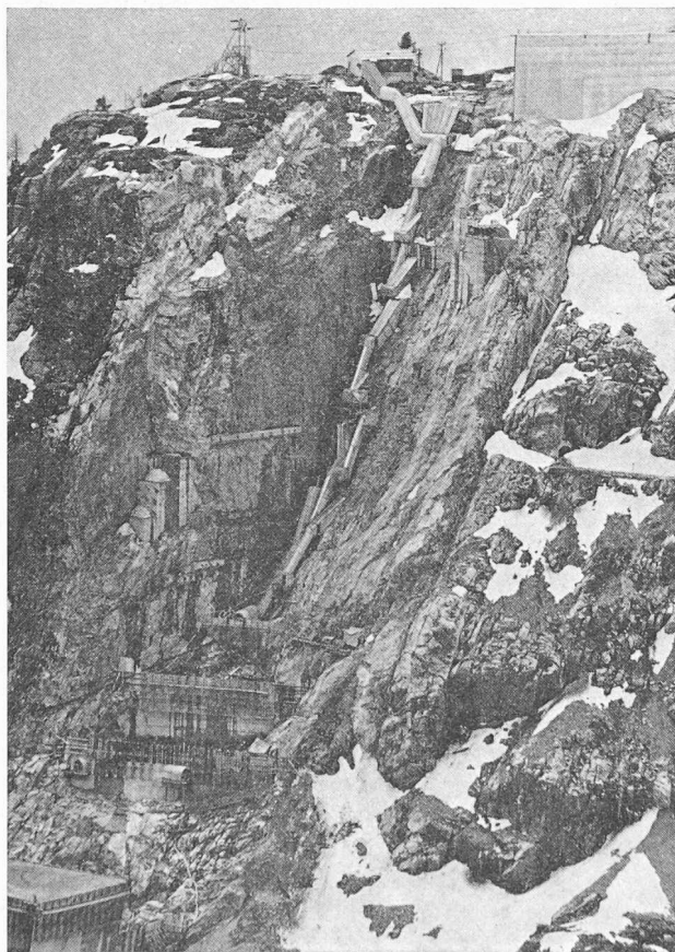
Fig. 12. — Le flanc droit après achèvement de l'excavation supplémentaire jusqu'à la zone de broyage découverte en octobre 1969. (Photo R. Hediger.)
