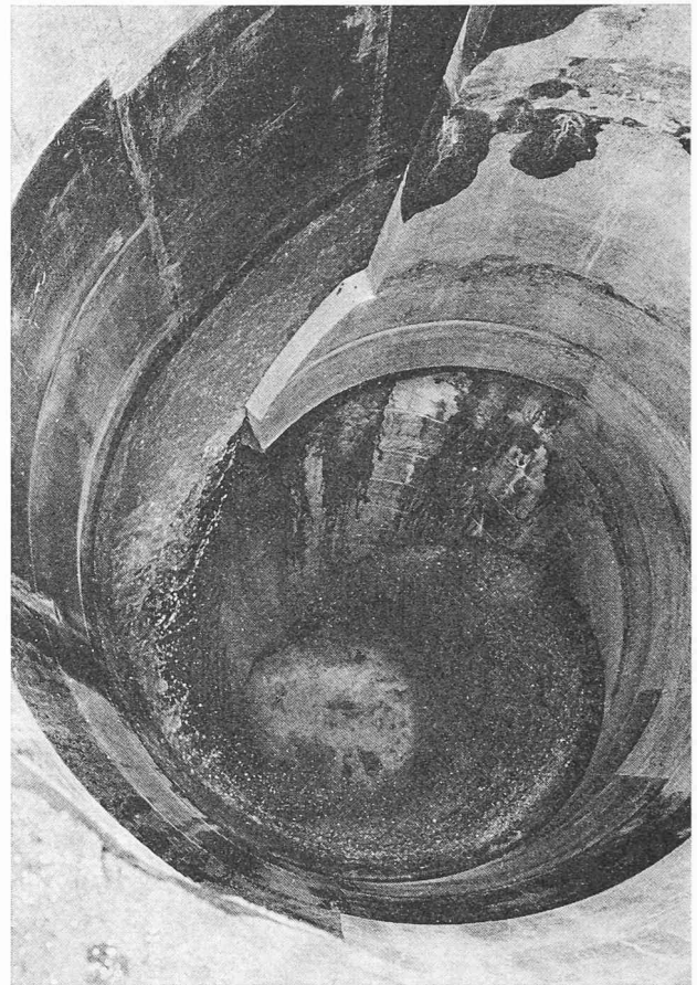
Fig. 15. — Chambre spirale d'un puits de chute. (Photo Conrad Zschokke SA, Genève.)
