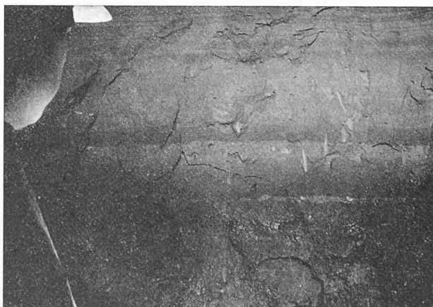
Fig. 7. — Apparition de la stratification des formations limono-sableuses de la Prairie au front de taille de la GT (photo M. Odier).
