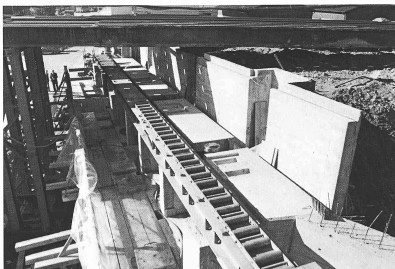
Fig. 189. — Passage inférieur de Malley. Détail du dispositif d'abaissement de la dalle schématisé à la figure 188. En bas à gauche, sous la colonne métallique, on distingue l'empilage des galettes de béton fretté.
