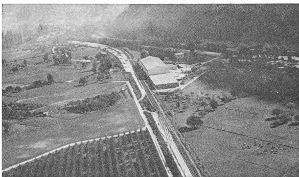
Fig. 174. — A proximité de Viège, la nouvelle voie est raccordée provisoirement à l'ancienne en attendant la construction anticipée du passage inférieur de la future jonction à la RN 9. Dans le fond, la plate-forme élargie de l'entrée de la gare.
