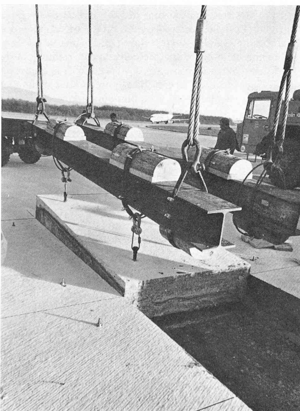
Fig. 2. — Enlevage à la grue des morceaux de dalles sciés.
